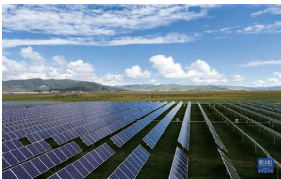
这是位于四川省阿坝州红原县邛溪镇麻萨村的花海光伏电站（2021年8月14日摄，无人机照片）。新华社记者 江宏景 摄
