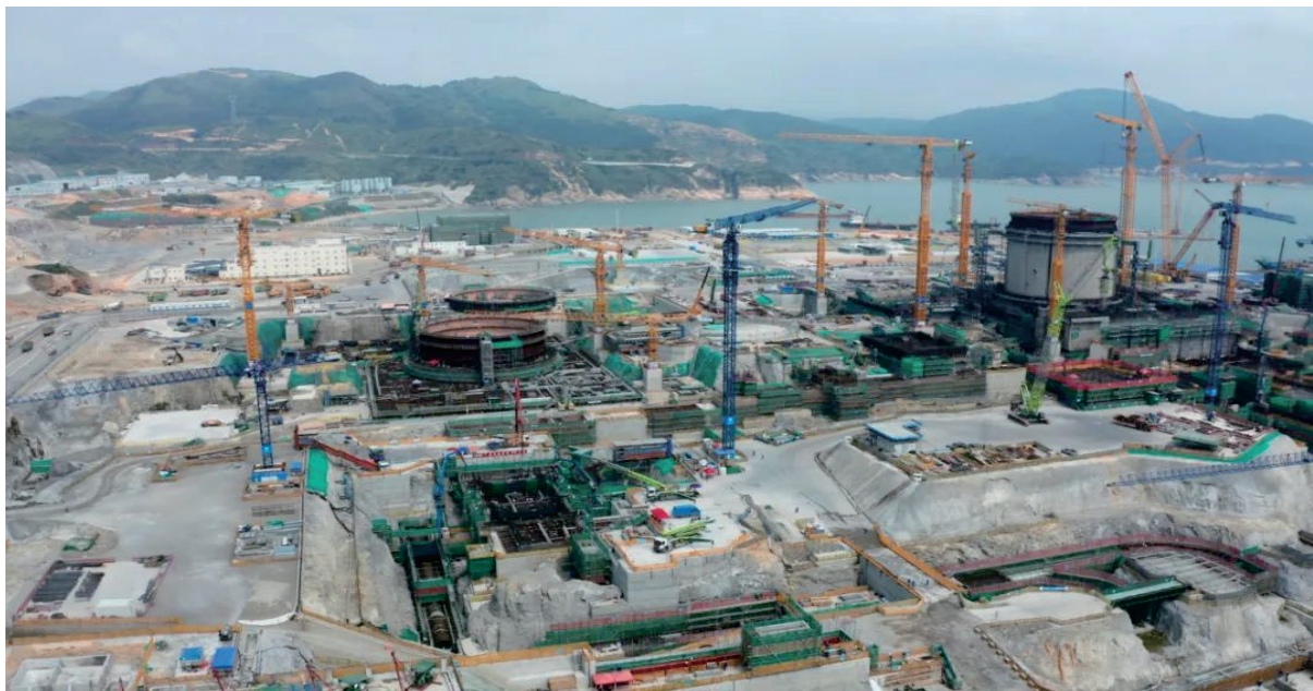
中广核浙江三澳核电项目一期工程建设现场
