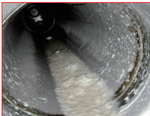
图3 浆糊状水溶纸随高压冲洗水流出
