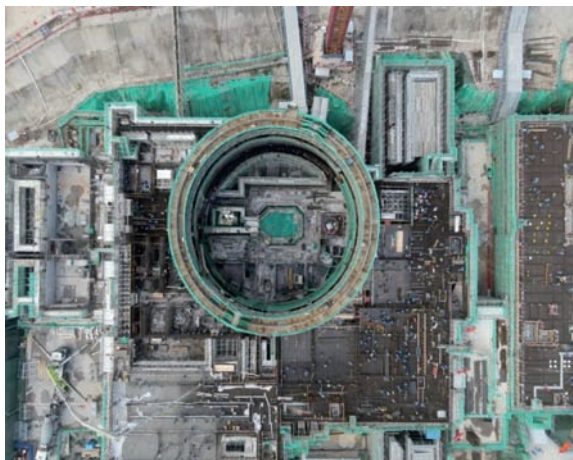
“玲龙一号”全球首堆海南昌江多用途模块式小型堆核岛安装工程施工现场
